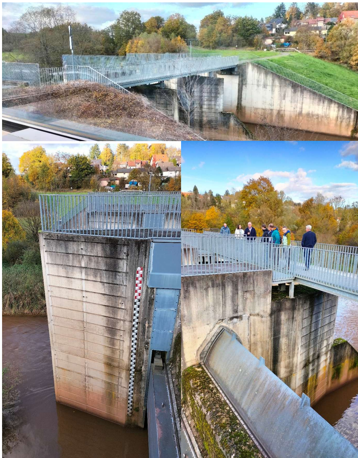
Abbildung 2: Eindrücke vom Hochwasserrückhaltebecken Ottweiler.
