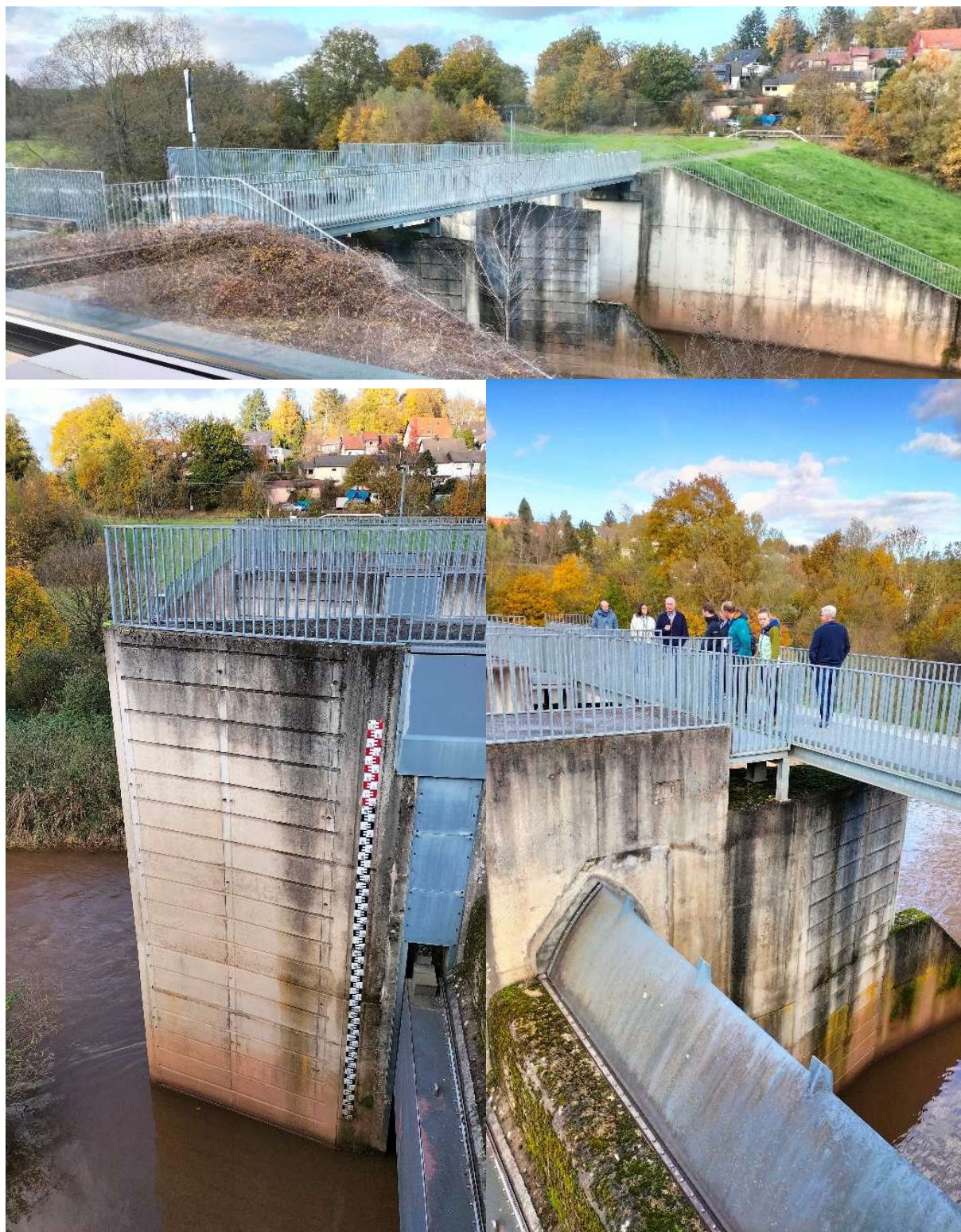
Figure 2 : Impressions du bassin de rétention des eaux de crue d'Ottweiler.
